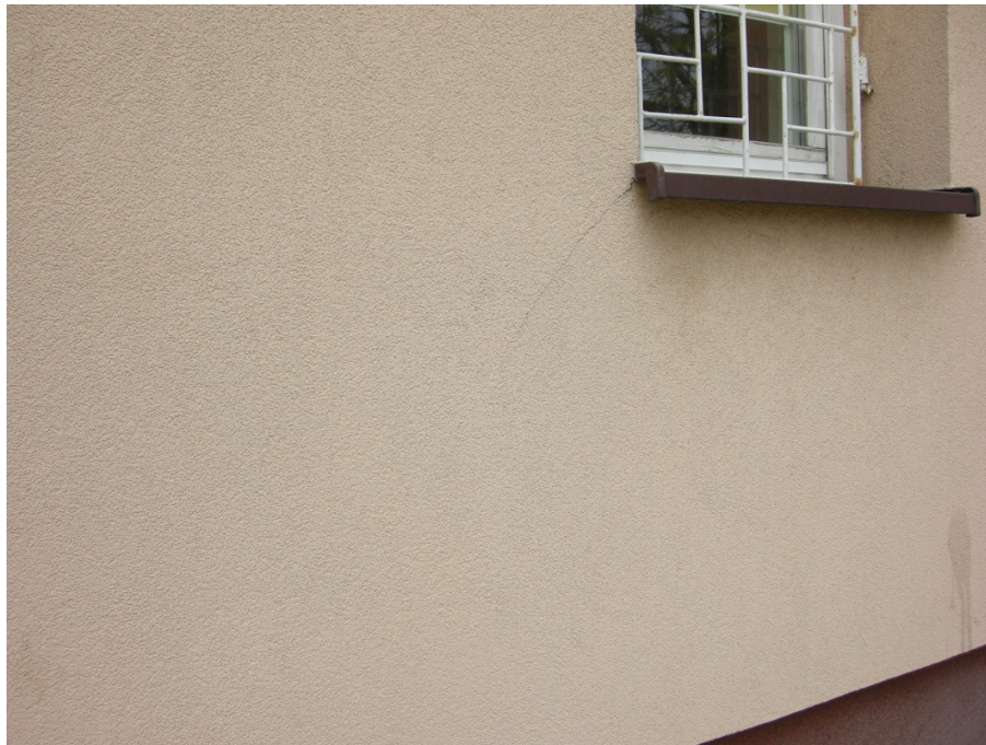
Zdjęcie nr2 – widoczna rysa na elemencie elewacji- przyczyna: brak siatki w narożach
