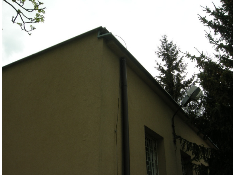
Zdjęcie nr1- połączenie gzymsu ze ścianą nośną i szczytową- stan dobry brak widocznych rys
