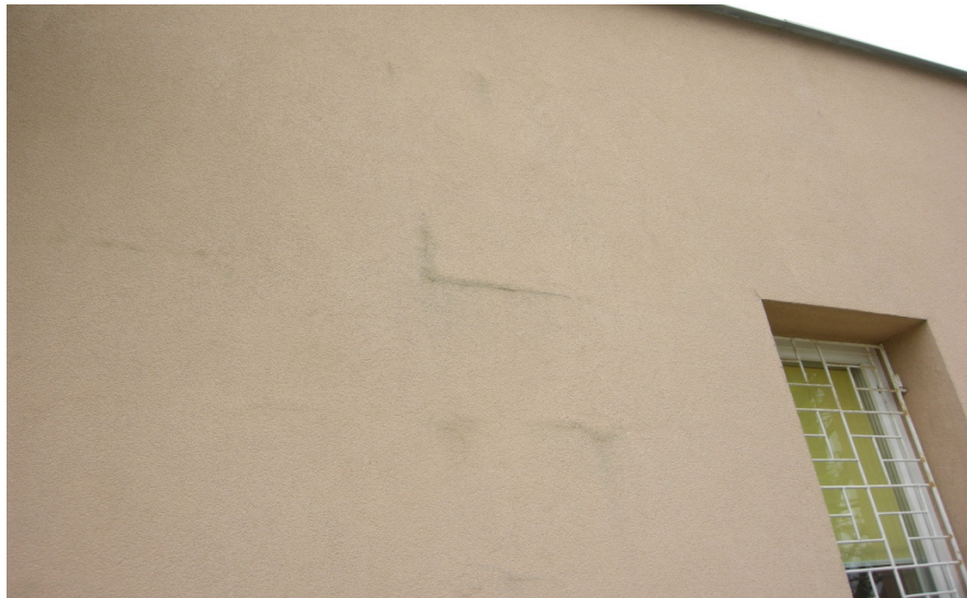
Zdjęcie nr3 – widoczna rysa na złączach płyt styropianowych-przyczyna: złe zamocowanie płyt styropianowych
